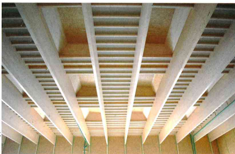
Montage der Binder für die Sporthallen Süd mit Akustikplatten-Untersicht und abgedecktem Oberlichtkranz. Dachelemente aus KVH-Pfetten und OSB-Beplankung stabilisieren die 27,50 m langen Satteldachbinder.
