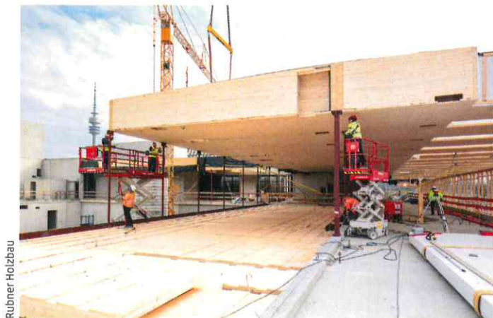
Jedes Hohlkasten-Element ruht auf vier filigranen Stahlstützen - zwei in Fassadenebene unter dem blockverklebten BS-Holz-Querträger und zwei am hinteren Ende.
