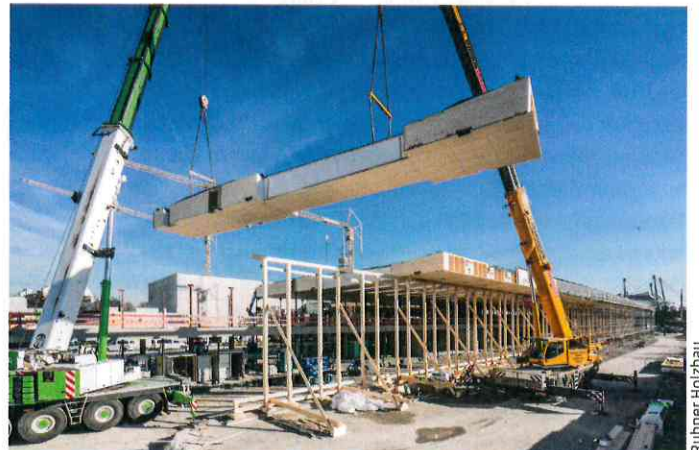
Ein Leegerüst am Ende der Auskragung stützt die Vordach-Elemente während der Montage. Auch zahlreiche andere Abspannungen fixieren die teilmontierten Dachbereiche.
